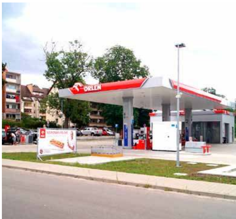
Stacja paliw znajdująca się na ulicy Łużyckiej
