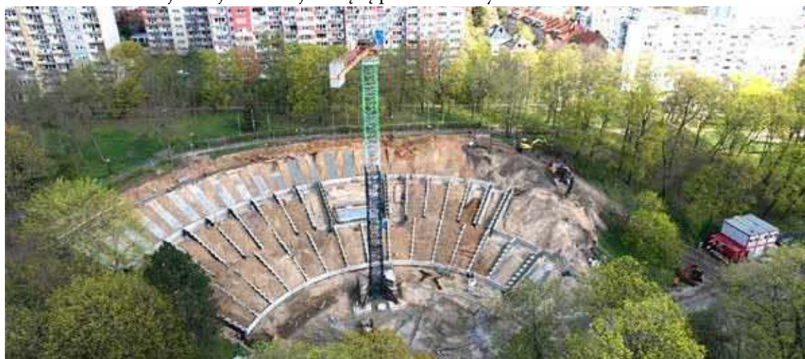
Prawie gotowe są już wszystkie elementy konstrukcyjne trybun – m.in. ściany oporowe i ławy fundamentowe
