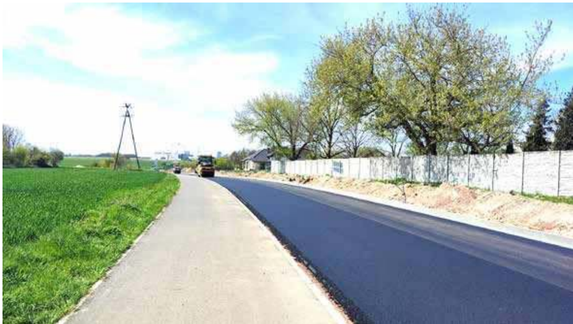
Na fragmencie ul. Lotników pojawiła się już nawierzchnia bitumiczna
