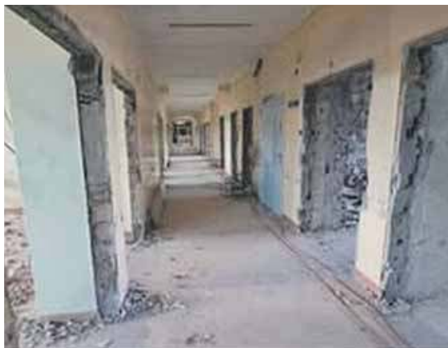
Trwa remont na III piętrze, gdzie powstają nowoczesne wnętrza oddziału neurologicznego
