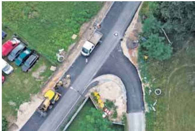
Na budowie widać postępy prac
