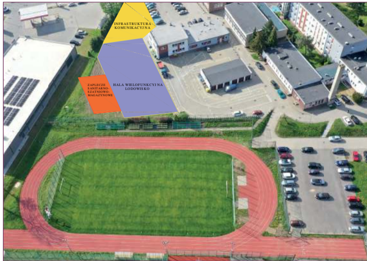
Zaplanowany obiekt lodowiska będzie ostatnim elementem kończącym tworzenie powiatowego kompleksu sportowego
