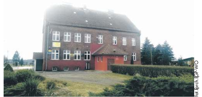
Publiczna Szkoła Podstawowa w Wójcicach. Od września formalnie będzie to dodatkowy budynek PSP w Minkowicach Oławskich
