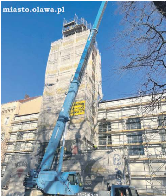
Trwa remont wieży przy kościele pw. Świętych Apostołów Piotra i Pawła
