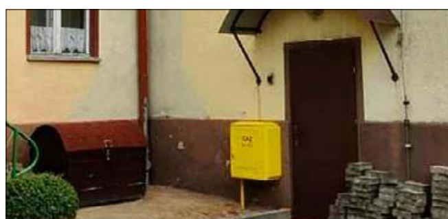
Skrzynka została zdemontowana i przeniesiona w inne miejsce.
