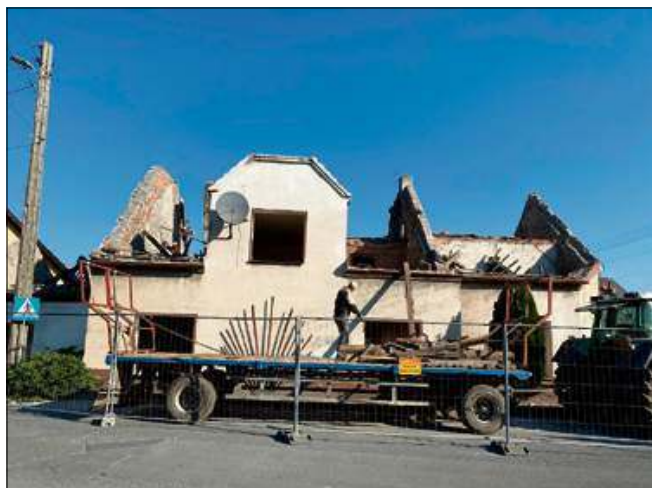
Rozbiórka budynku jest nieodzownym elementem przebudowy skrzyżowania.
