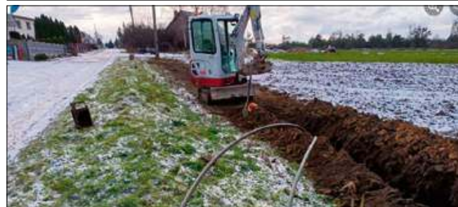
W Kamieniu Śląskim budowa światłowodu już ruszyła.
