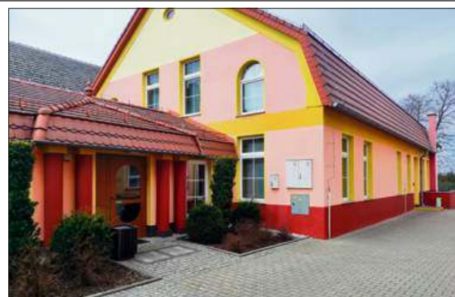
Czujnik został zamontowany na budynku GOK-u w Strzeleczy.
