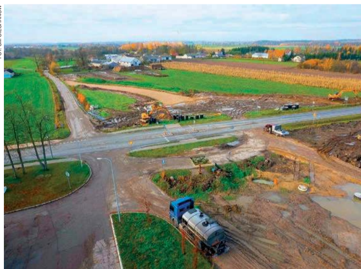
W tym miejscu przebiegać będzie nowy odcinek obwodnicy
