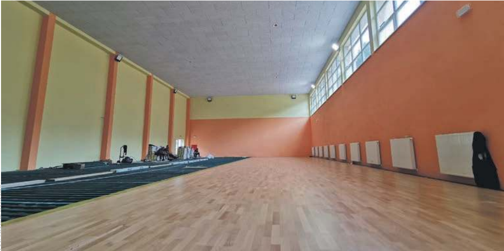
Robotnicy kładą parkiet w nowej sali gimnastycznej w Jankowicach
