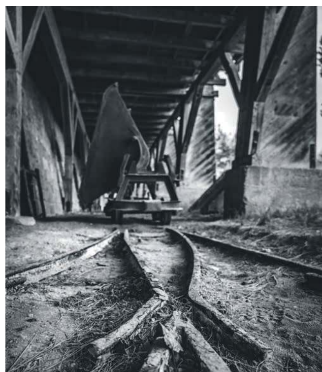
Pozostałości torów, po których poruszały się wagony transportujące surowiec
