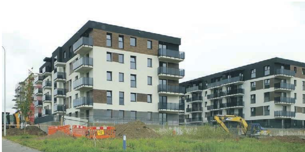
Nowe osiedle powstaje w Krzeszowicach
