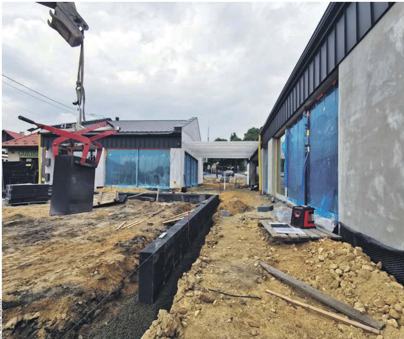
Trwa budowa nowych pawilonów handlowych w Babicach
