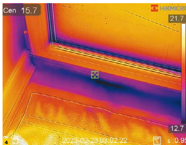
FOT. 3-4 Brak ocieplenia progu albo ciepłego profilu bazowego skutkuje powstaniem mostka termicznego; fot.: autor
