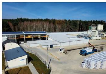
ZAKŁAD BETONÓW W LIPIU
