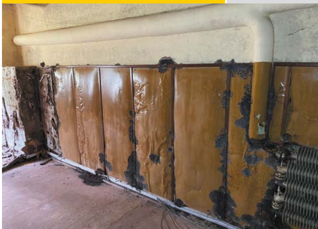
FOT. 2 Elementy boazerii, pod którymi rozwinął się stroczek domowy; fot.: autor
