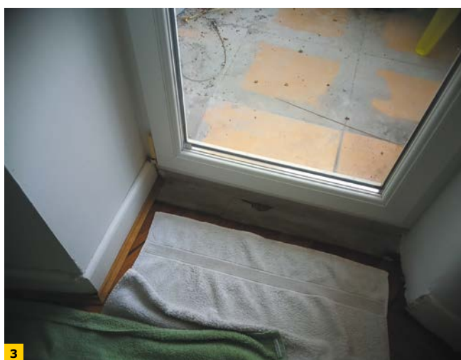
FOT. 3-4 Brak ocieplenia progu albo ciepłego profilu bazowego skutkuje powstaniem mostka termicznego; fot.: autor
