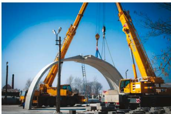
ZAKŁAD BETONÓW W KOLBUSZOWEJ - MONTAŻ ELEMENTÓW ŁUKOWYCH
