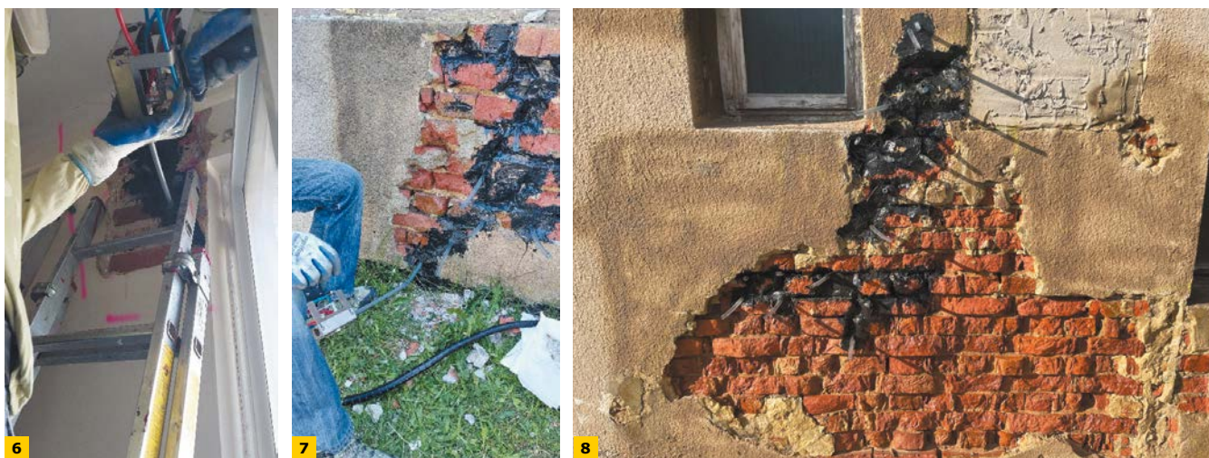
FOT. 6–8 Iniekcja złączy polimerowych FlexAndRobust; fot.: archiwum autorek
