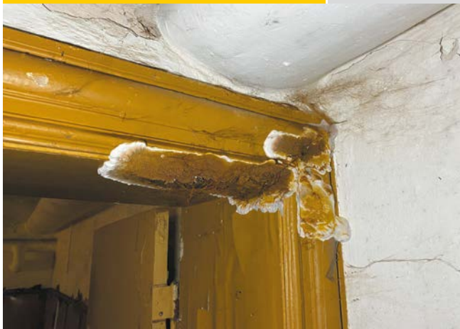
FOT. 9 Owocnik koloru czerwobrazowego z białą mięsistą krawędzią; fot.: autor
