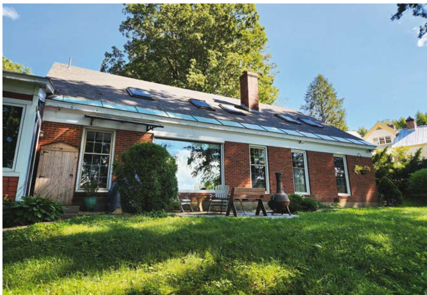
FOT. 1 Jedną z kluczowych korzyści wymiany okien dachowych jest obniżenie rachunków za ogrzewanie
