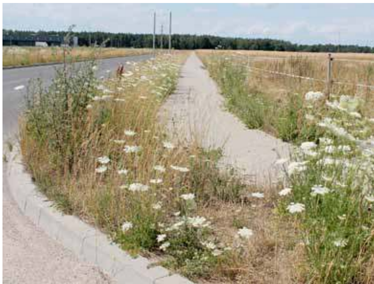
Tak wygląda chodnik przy strefie - zdjęcie od strony Wojcieszyna
