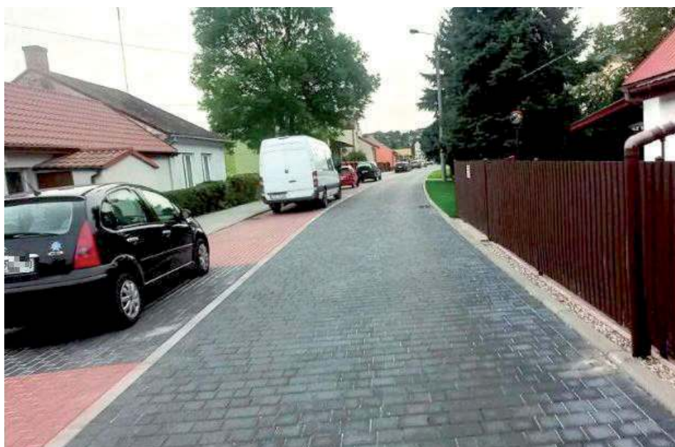
Prace były prowadzone m.in. na ul. Nadwalnej
