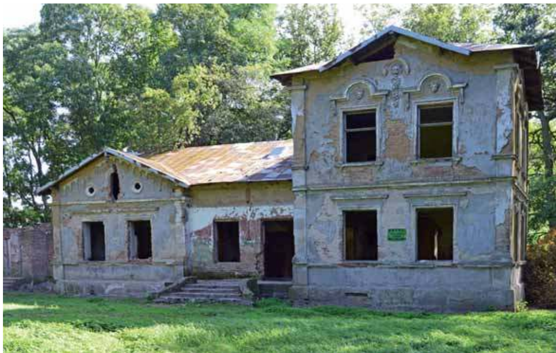
Przy dworku w Kliczewie Małym prowadzone są prace porządkowe
