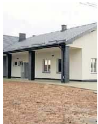
Zakończyła się budowa Domu Ludowego i strażnicy.
