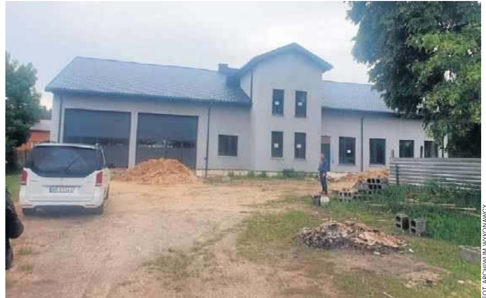
Budynek strażnicy i świetlicy w Suchej w gminie Białobrzegi ma już elewację, dach, wstawione są okna i brama garażowa. Obecnie trwają tutaj prace przy instalacjach.
