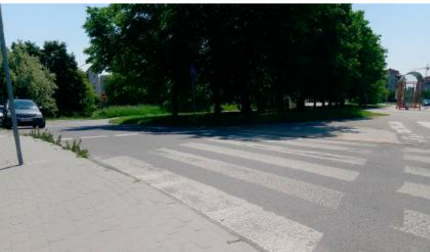
Ostrzegawczego pasa płytek brakuje m.in. po jednej stronie przejścia na ul. Oratoryjnej
