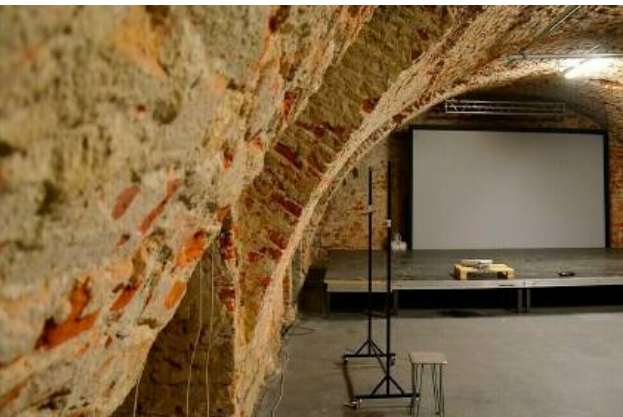
Adaptacja piwnic klasztoru powiżytkowskiego kosztować będzie prawie 6,5 mln zł
