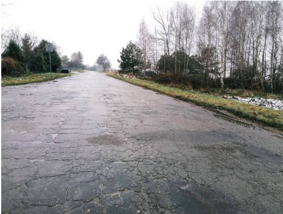
Droga z Głuska do Wolicy i dalej prowadząca w kierunku Kowali jest w opłakanym stanie. Asfalt jest popękany. Są koleiny i doły
