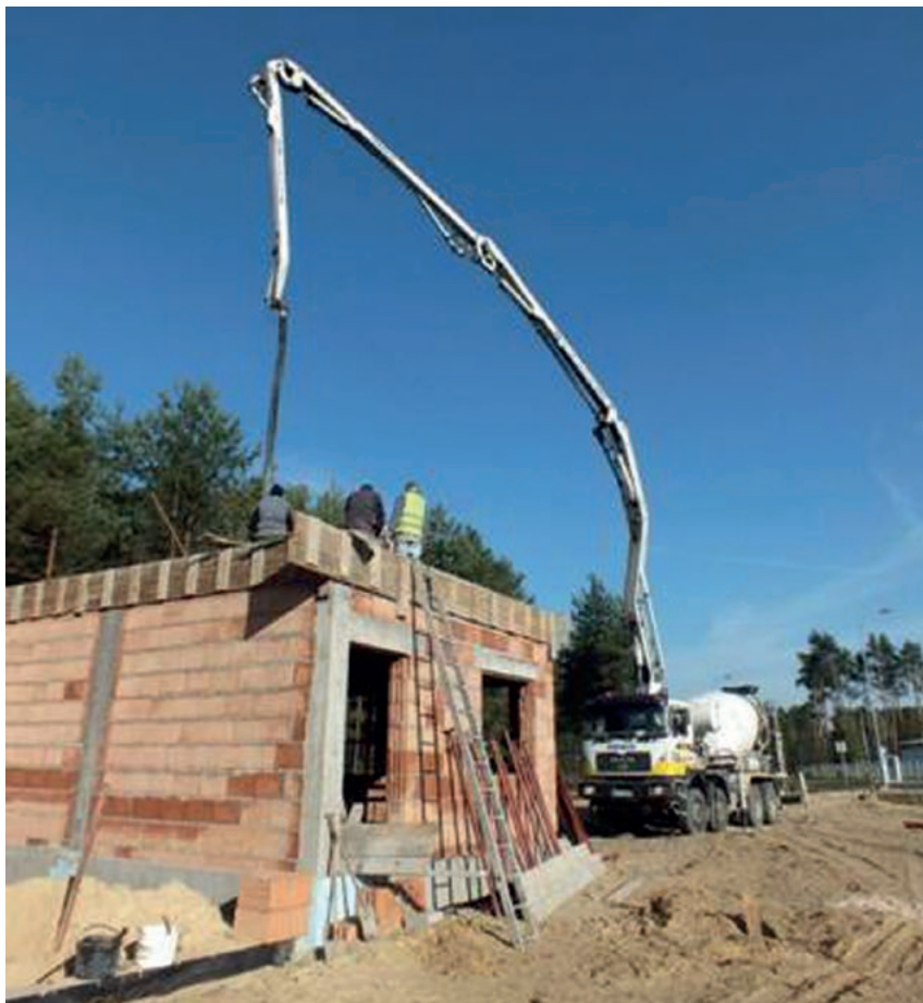
Budowa Rupיעiarni 2 przy ulicy COP
