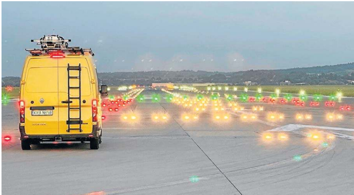
Trwają prace przy modernizacji oświetlenia drogi startowej
