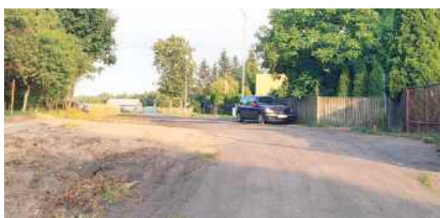
W ramach inwestycji na gruntowej do tej pory ulicy Kondrackiego powstaną: nowa nawierzchnia jezdni na długości 619 m i bezpieczny chodnik o szerokości 2 m
