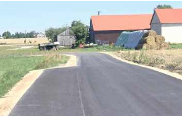
Prace modernizacyjne objęły odcinek o długości 682 metrów
