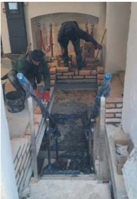
Obecne prace w kryptach
