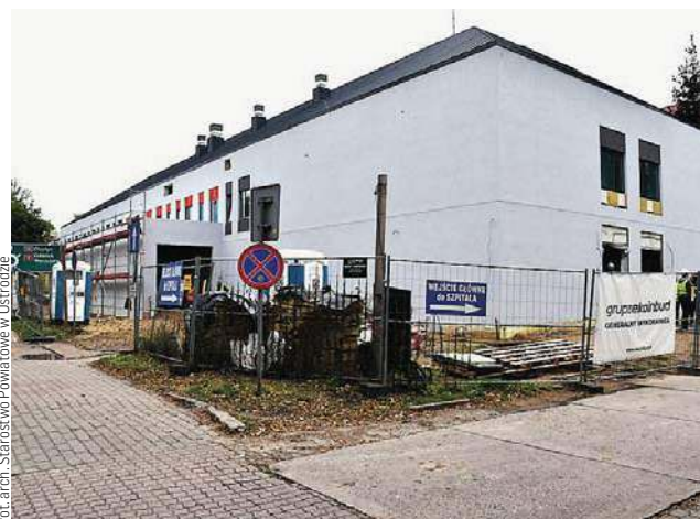
„Drewniane” skrzydło szpitala w Ostródzie
