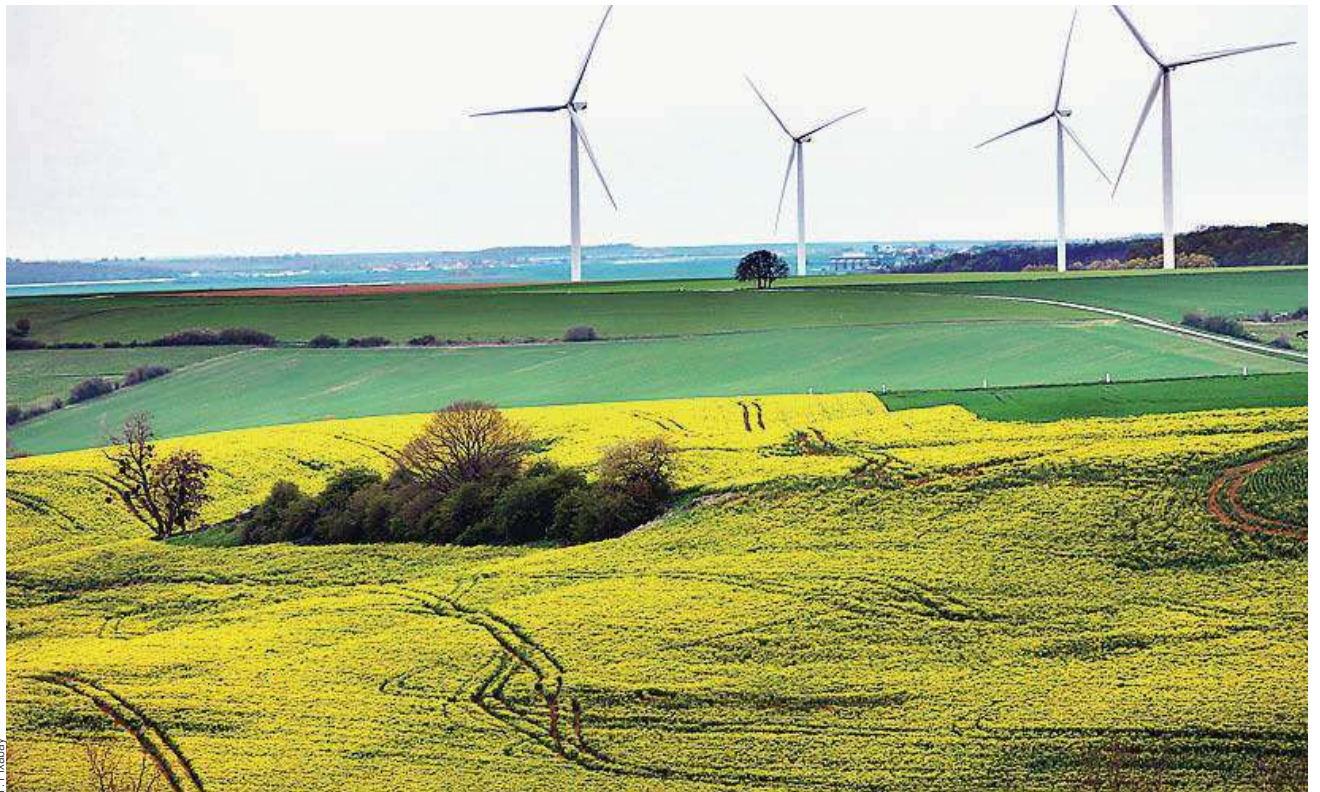
Grupa PGE po tej transakcji posiada w swoim portfelu elektrownie wiatrowe o łącznej mocy blisko 800 MW
