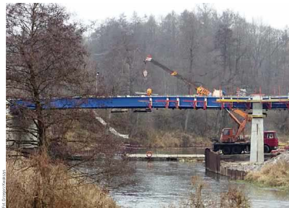
Na tempo prac przy budowie mostu wpływają m.in. dobre warunki pogodowe
