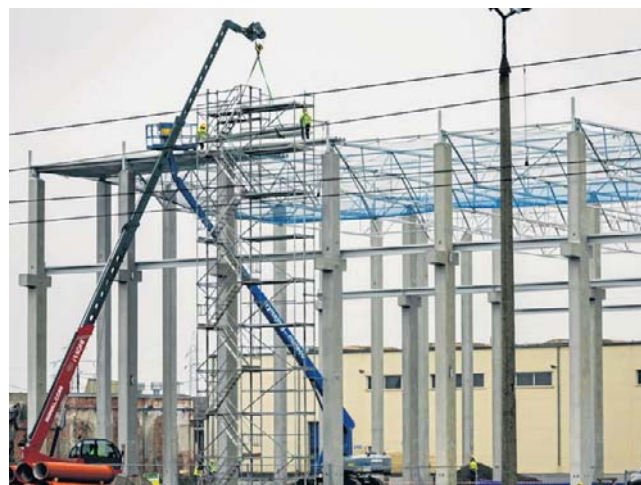
PESA właśnie finalizuje wartość 500 mln zł budowę hali magazynowej z zapleczem socjalno-bytowym oraz halą montażową z konieczną infrastrukturą.
