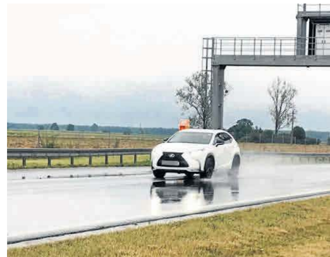
Na odcinku A1 koło Kutna po intensywnym deszczu woda spływa zbyt wolno i tworzą się kałuże zagrażające kierowcom
