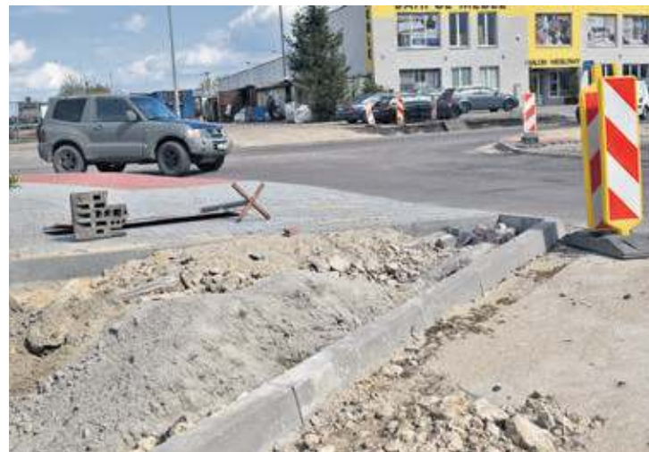
Na skrzyżowaniu trwają jeszcze prace, dlatego znaków wciąż brak.
