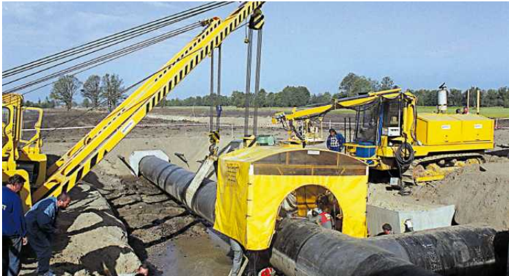
• Chelsty, zakończenie budowy pierwszej nitki gazociągu Jamalskiego. 2 września 1999 r. FOT. ZDZISŁAW LENKIEWICZ/PAP
