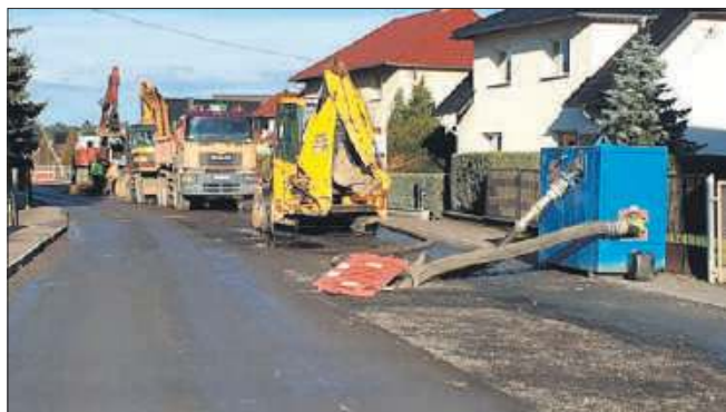
Prace idą pełną parą.
