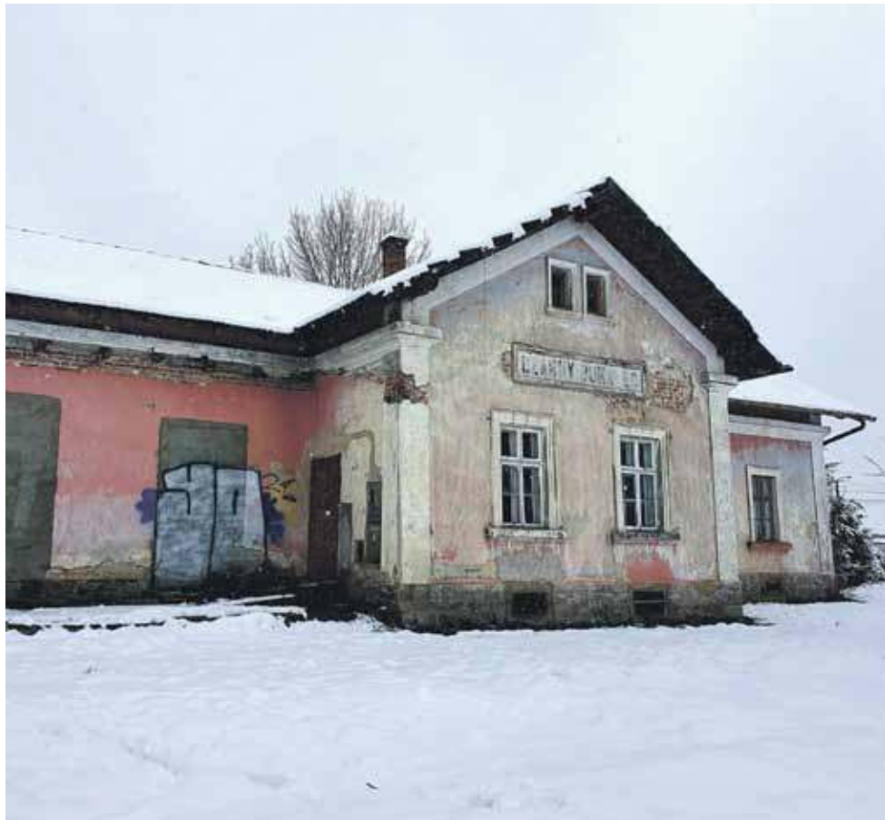
Stacja kolejowa w Czarnym Dunajcu doczeka się remontu. Będzie to kolejny tego rodzaju obiekt, który gmina odnowi. Wcześniej został wyremontowany zabytkowy dworzec w Podczerwonym.
