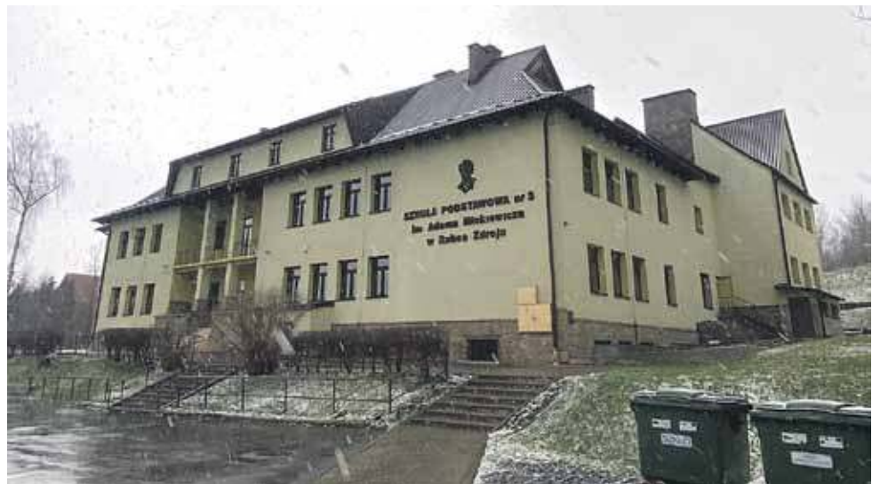
Nowe pomieszczenie zostało wygospodarowane na poddaszu obiektu.
