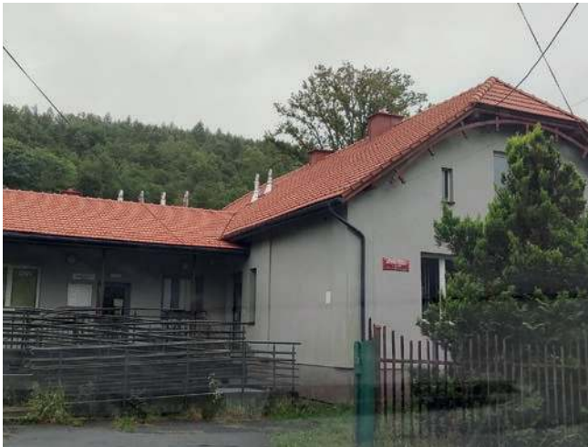
Nowy dach na ośrodku zdrowia w Regulicach
