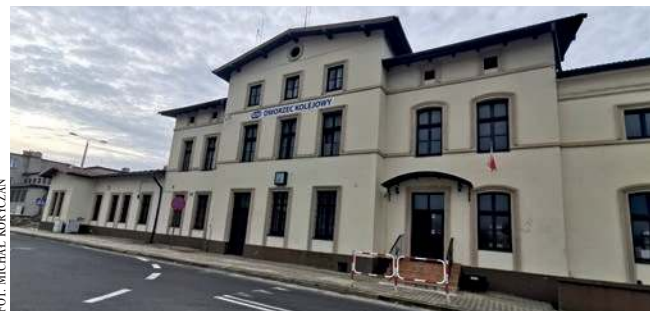
Budynek dworca kolejowego w Trzebini
