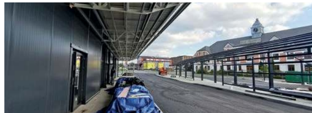
Trwa budowa centrum przesiadkowego w Trzebini
