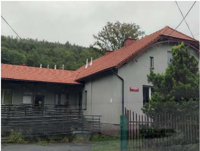
Nowy dach na ośrodku zdrowia w Regulicach
