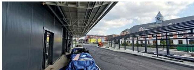
Trwa budowa centrum przesiadkowego w Trzebini
