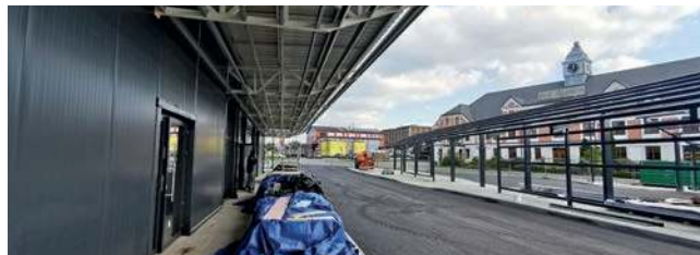
Trwa budowa centrum przesiadkowego w Trzebini
