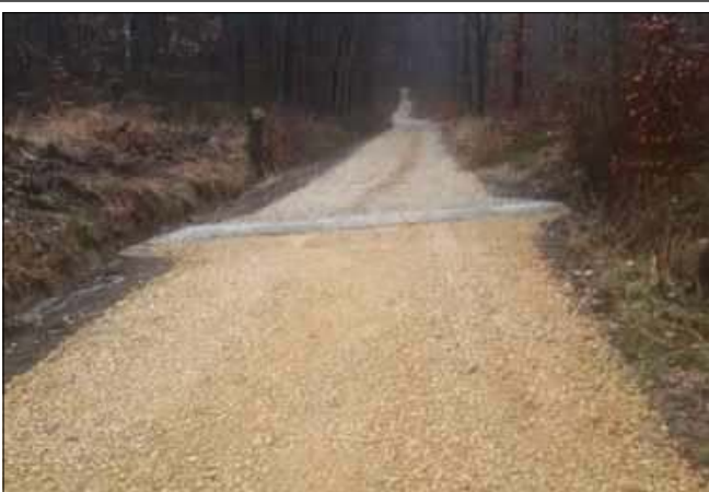
Tak prezentuje się droga po wykonanych robotach.
