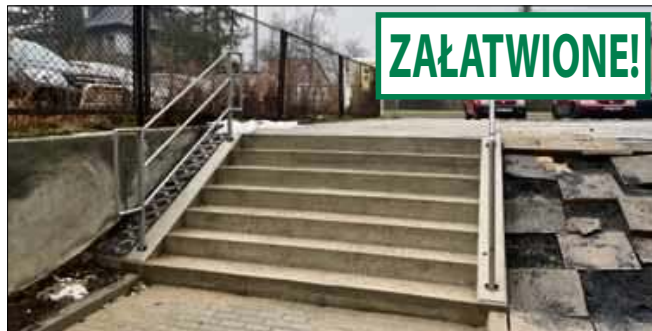
Po naszej interwencji zamontowano poręcz.
