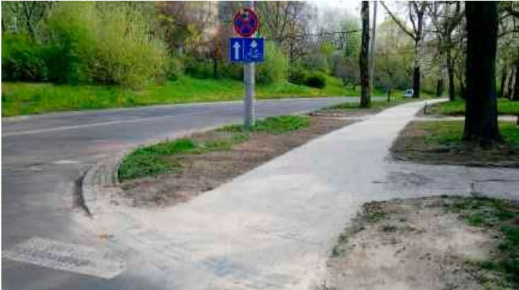
Wyremontowany chodnik przy ul. Wileńskiej
