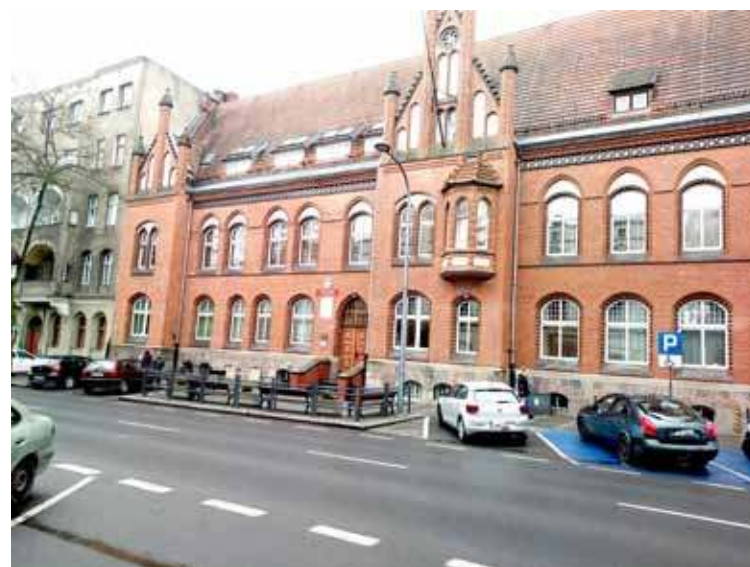
Urząd Miejski poinformował o zamiarze budowy jednostronnego ciągu pieszo-rowerowego w pasie drogowym ul. Nasiennej
