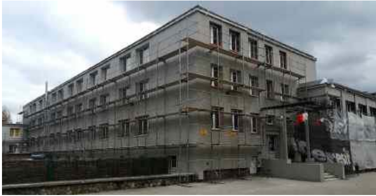
Termomodernizacja „Budowlanki” idzie pełną parą
