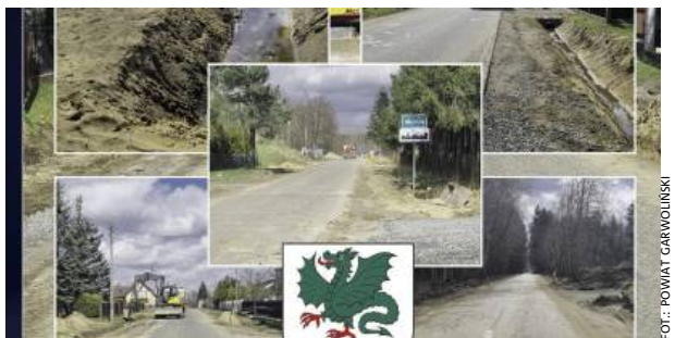
Drogi przeznaczone do przebudowy lub remontu
