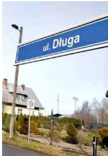
Na ok. 200 metrowym odcinku ul. Długiej w Morzyczynie brakuje lamp
