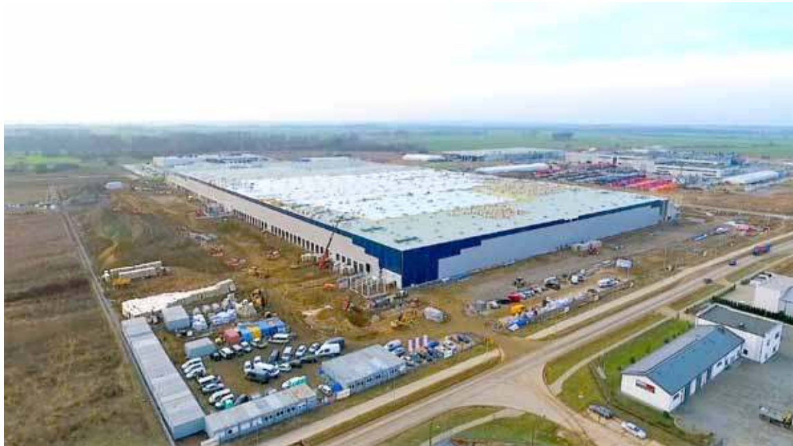
Gigantyczne centrum logistyczne o powierzchni 87 300 m 2 jest budowane w Parku Przemysłowym Nowoczesnych Technologii
