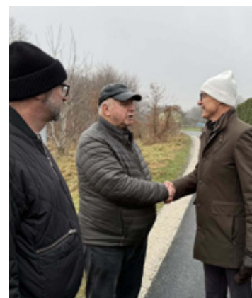
Ulica Nasypowa - odbiór prac budowlanych.
