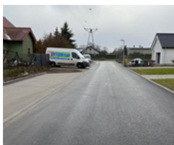
Wyremontowana ulica Zbożowa.
