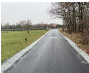
Wyremontowana ulica Nasypowa.
