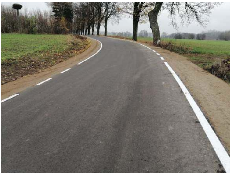
Remont (odnowa) drogi powiatowej nr 1265N od km 2+124 do km 4+922 o dł. 2,798 km, od gr. powiatu przez Gąsiorowo do skrzyżowania z drogą pow. nr 1284N
