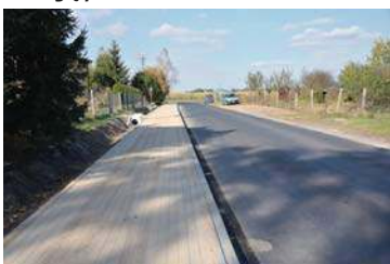
Budowa chodnika o długości około 120 m w miejscowości Cibórz, w ciągu drogi powiatowej nr 1294N
