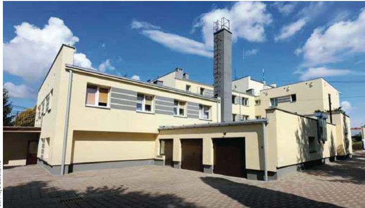
Wyremontowane budynki dps w uzdowie
