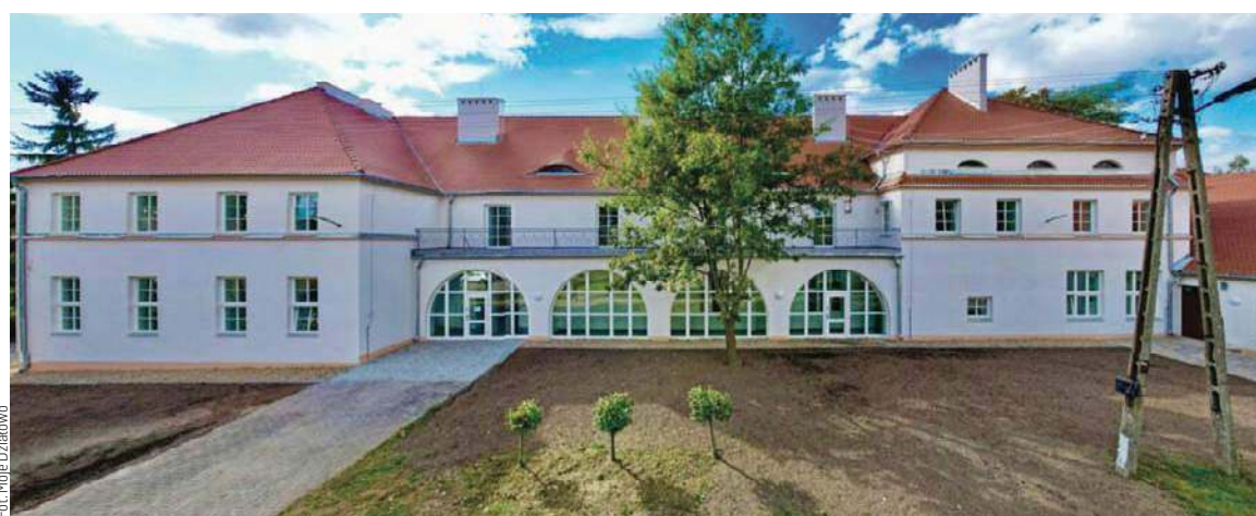
Termomodernizacja budynków ZS w Malinowie
