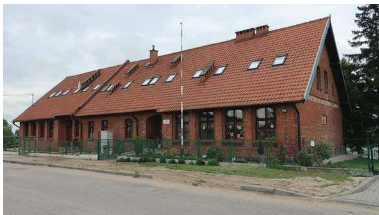
Wyremontowany budynek placówki opiekuńczo-wychowawczej Dom dla dzieci Na zielonym wzgórzu w Grzybinach
