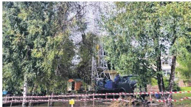
Prace na działce nieopodal Krzeszowickiego Centrum Zdrowia
