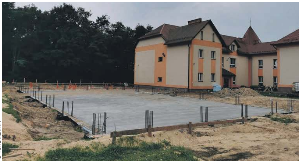
Przy szkole w Jankowicach powstaje sala gimnastyczna
