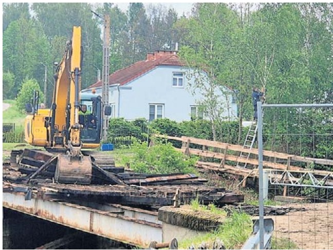
Wykonawca rozpoczął prace przy przebudowie mostu. Nowy obiekt żelbetowy ma być gotowy końcem 2026 r.
