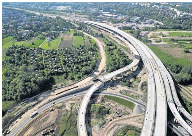
Wykonano ostatnie betonowanie na węźle Mistrzejowice S7
