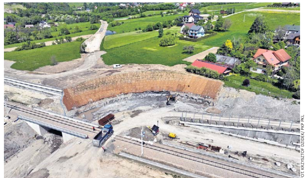
Tak wyglądają prace przy stabilizacji skarpy pod wiaduktem w Kłodnem
