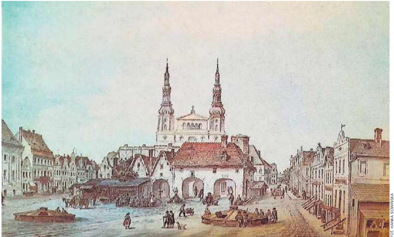
Widok na ratusz, kościół Jezuitów (konsekrowany w 1649 r., przy świątyni działał teatr szkolny i bursa muzyczna) i zachodnią pierzeję rynku bydgoskiego z 1810 r. (P. Jaeckel, akwarela). Widoczny na pierwszym planie ratusz został wybudowany na początku XVI w., rozebrany w drugiej połowie XIX w. Zarys odkrytych przez archeologów fundamentów (XX-XXI w. jest zaznaczony na płycie rynku)
