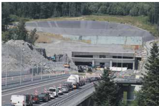
Południowy wlot tunelu
