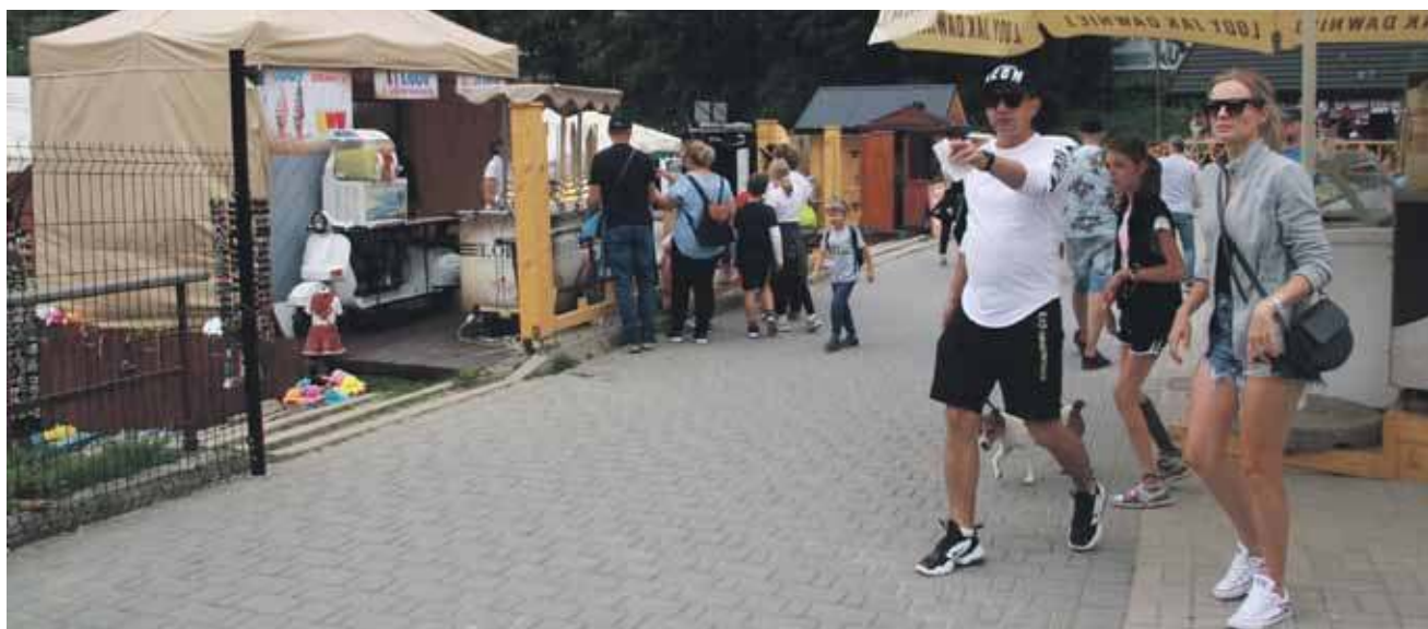
Po zdemontowanym drewnianym płocie na placu pod Palenicą w Szczawnicy zostały tylko filary.
