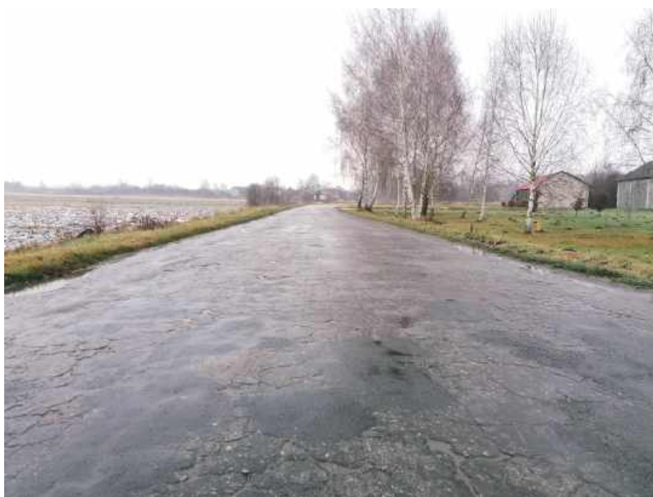
Do wykonania pozostał 3,2-kilometrowy odcinek drogi powiatowej relacji Głusko – Wolica – Kowala
