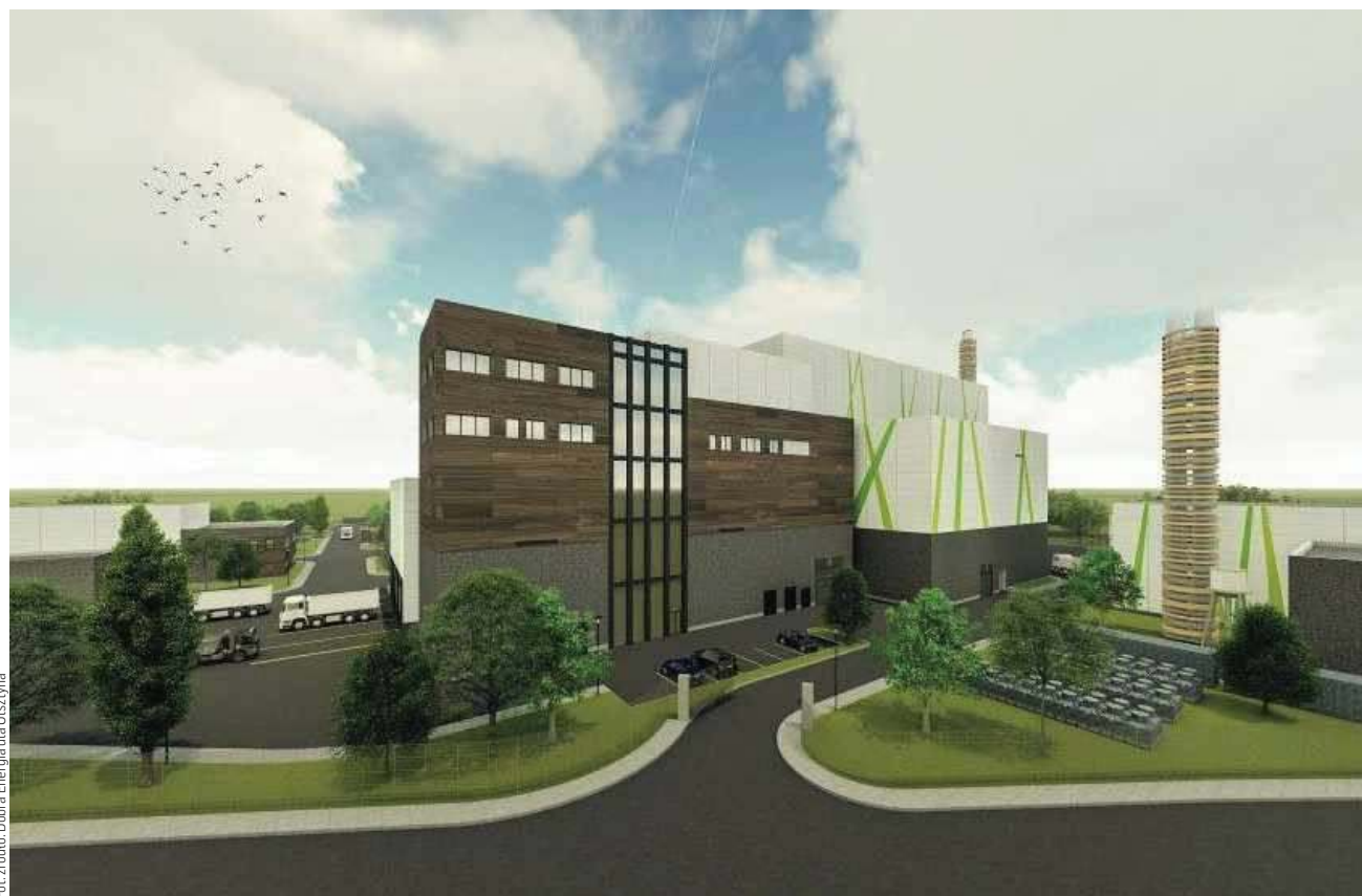
Powstająca w formule PPP w stolicy Warmii i Mazur instalacja termicznego przekształcania odpadów z odzyskiem ciepła i energii elektrycznej (w skrócie ITPO), to inwestycja, która zmieni Olsztyn i region
