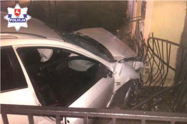
Mazda 12 grudnia po 1 w nocy uderzyła w ogrodzenie i ścianę. Zniszczyła dwa przeszły, elewację i naszą skrzynkę na listy
