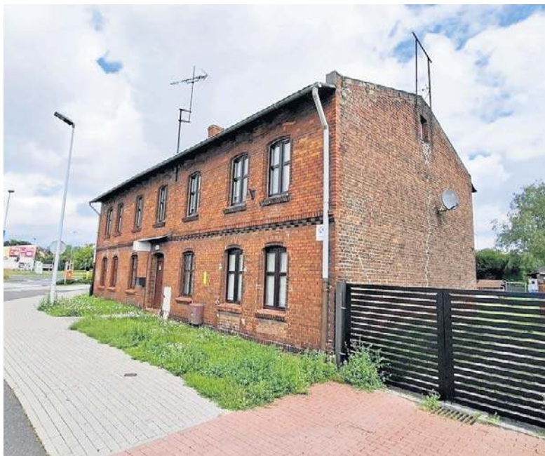
Budynek przy Szosie Chełmińskiej 110 ma zostać wyremontowany
