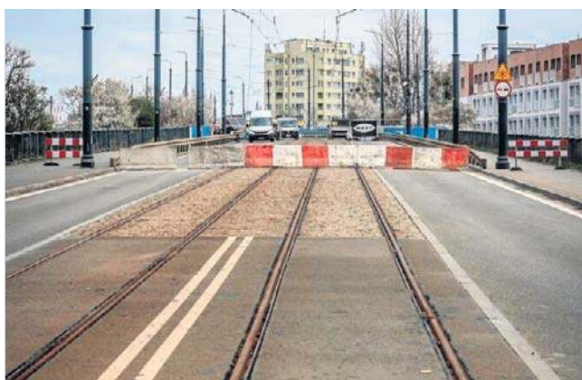
W piątek miasto ogłosiło przetarg na prace remontowe całej konstrukcji, które potrwać około dwóch lat
