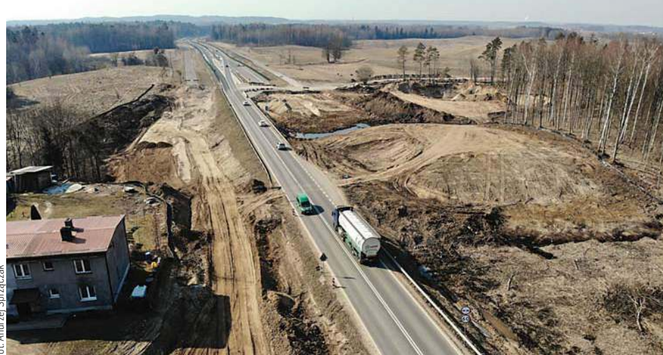
Budowa S16 Borki Wlk – Mrągowo powinna zakończyć się pod koniec przyszłego roku
