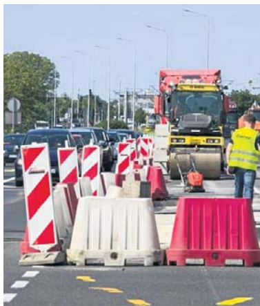
Trwa przebudowa torowiska tramwajowego
