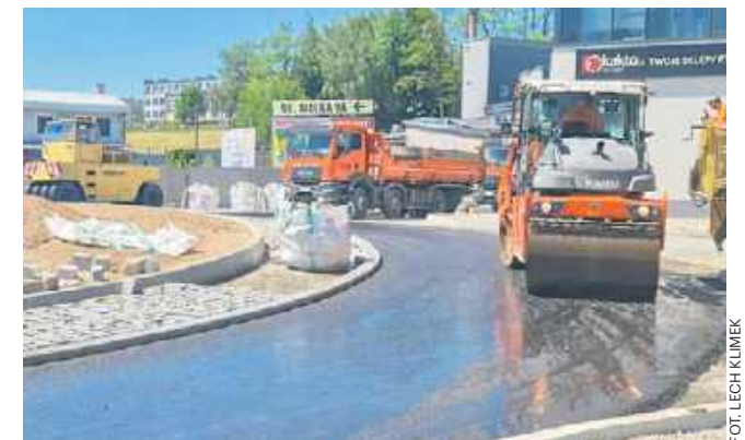
Drogowcy kładą asfalt na nowym rondzie u zbiegu ulic 11 Listopada, Korczaka oraz Bardiowskiej w Gorlicach
