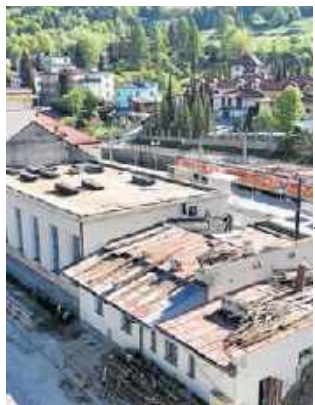
Totalny remont dworca kolejowego postępuje
