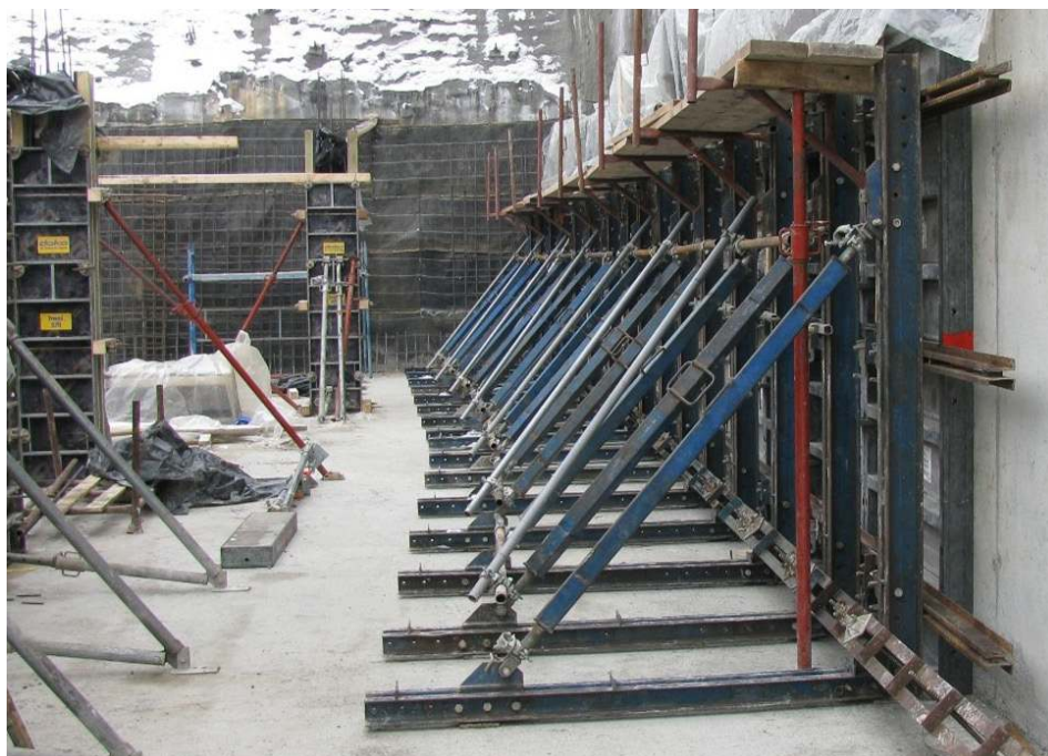
Fot. 1. Przykład deskowania jednostronnego
