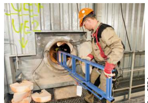
Fot. 4. Transport elementów dźwigu towarowego GEDA 300Z do kotła przez otwór o średnicy około 45 cm
