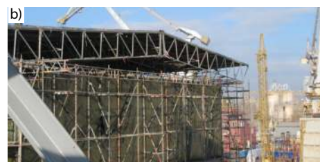
Fot. 2. Konstrukcja zadaszenia oparta na rusztowaniach modułowych – projekt i wykonanie: Xervon Polska Sp. z o.o.
