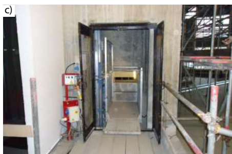
Fot. 3. Przykłady zastosowania dźwigu towarowego GEDA 300Z:
